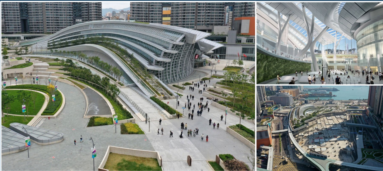
Estación Hong Kong HSR West Kowloon
