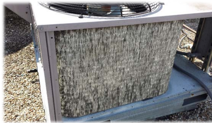
Damaged Fins
